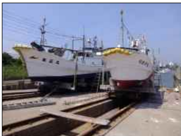
改修した上架施設
