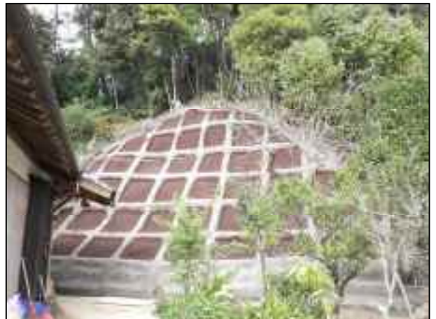
治山施設の設置
