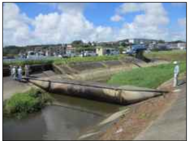
花ヶ島ラバー頭首工の点検
