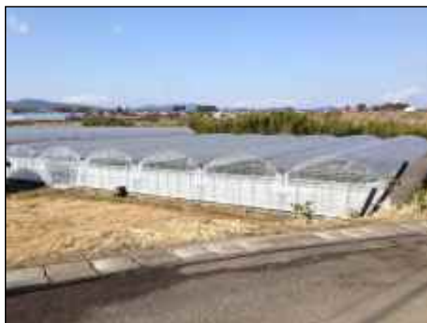
移設・補修して整備された中古ハウス
