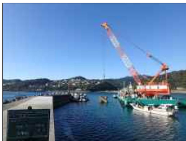
消波ブロックの据付
