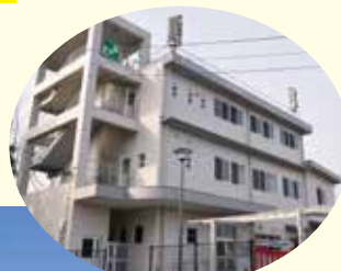
津波に備えて建設した島山避難施設
