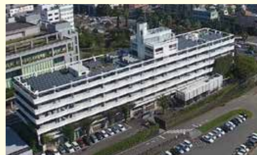
市役所本庁舎屋上に設置した太陽光パネル
