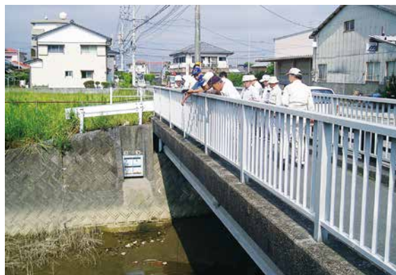
合同河川パトロール・水質検査
