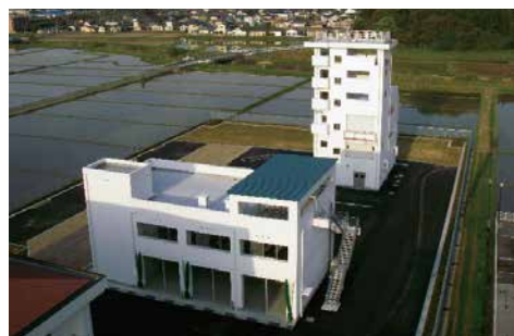
訓練塔、訓練研修施設(南消防署)
