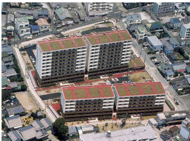
宮崎市営住宅権現団地
