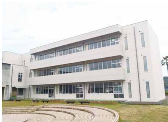
久峰中学校外壁落下防止対策事業
