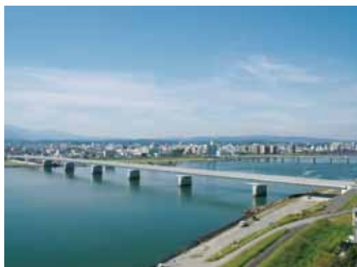
赤江大橋（平成20年11月開通）
