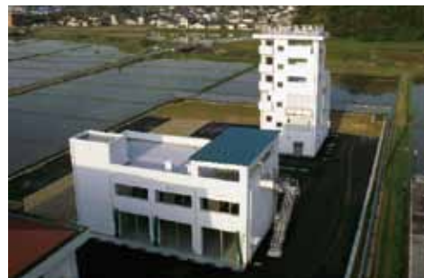
訓練塔、訓練研修施設(南消防署)
