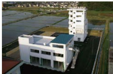
訓練塔、訓練研修施設(南消防署)
