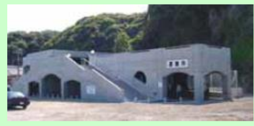
◆津波避難施設
