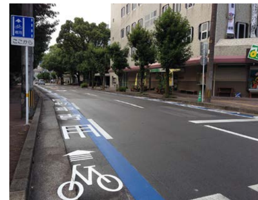
本町通線に整備した自転車レーン
