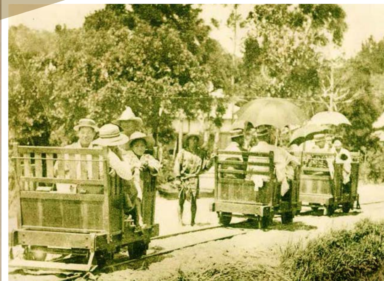
写真はかつての島之内千丈(せんじょう)地区(日向住吉駅南東側)辺り [写真提供/宮田節男さん]
