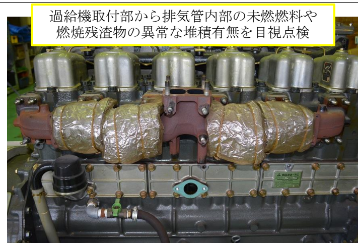
図2 排気管内部目視点検
