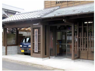
景観に配慮した店舗前面・看板
