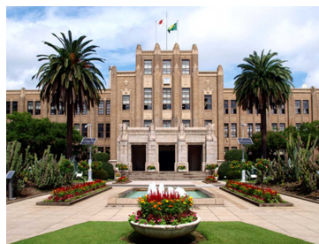
建築物 (宮崎県庁本館)
