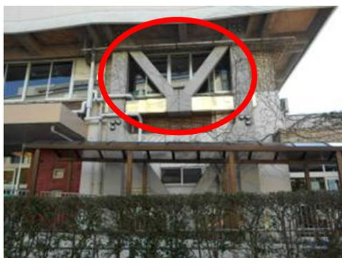
本庁舎耐震補強工事（制震ダンパー）
