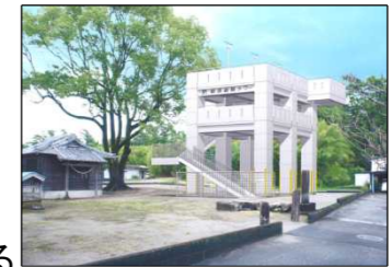
避難施設整備
