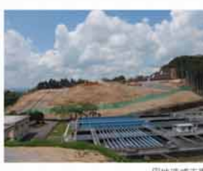
用地造成工事
