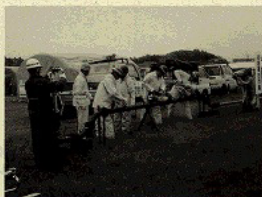
破損した水道管を復旧する訓練の様子
