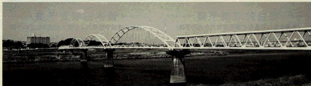
大淀川にかかる水管橋
