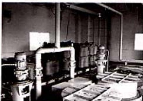
大淀川から取水した水に、取水ポンプ室で活性炭を注入することによって、その吸着作用により臭いや有機物を低減させます。
