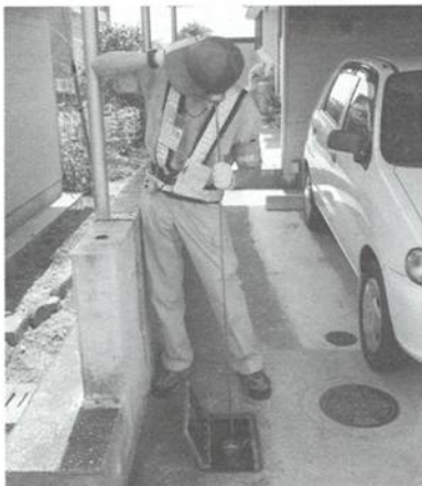
作業の様子（メータ部分）
