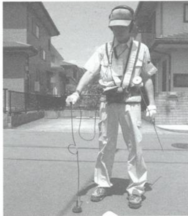
作業の様子（道路上）
