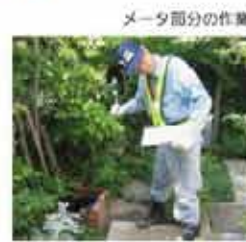
メータ部分の作業
