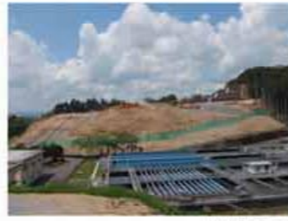
用地造成工事
