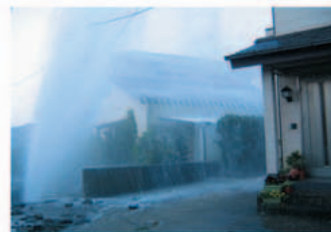
水道管から吹き上げる水道水(口径500mm)水道管からの漏水事故
