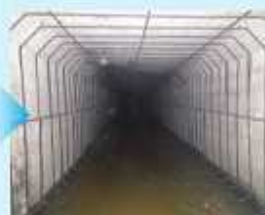
補強鉄筋組立
