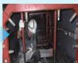
浮上防止兼支保工組立
