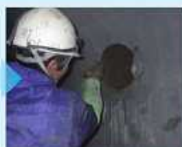
取付管口仕上工
