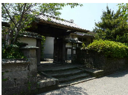
河上家武家門(景観重要建造物)
