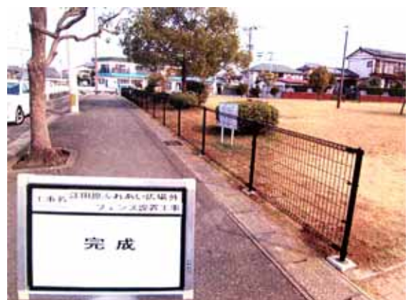
フェンス設置後
