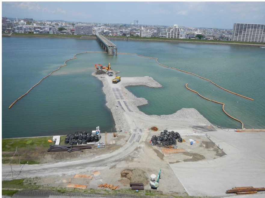
写真 6-3 小戸之橋の橋梁架け替え
