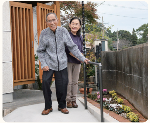
▲駐車場の出入りが便利になったと話す横山さん夫妻 ◀段差が大きかった裏口にも手すりを設置
