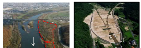
・河道掘削や樹木伐採 ・遊砂地等の整備
