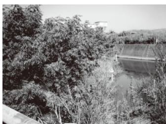
青柳川の堆積土砂に生えた樹木 （青柳排水機場付近）
