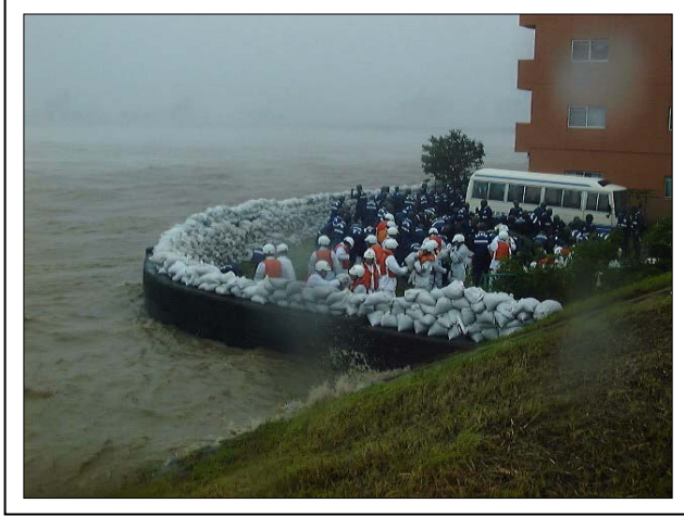
（自衛隊及び消防団などによる作業）
