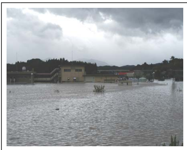
（富吉浄水場冠水状況）
