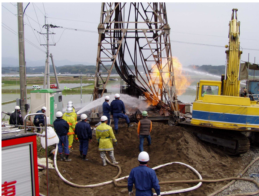
宮崎県消防相互応援協定により応援出動した災害 (西都市下三財 天然ガス火災 H15. 4. 8)
