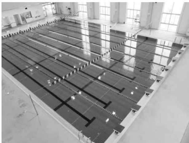
▲石崎の杜鯨館プール
