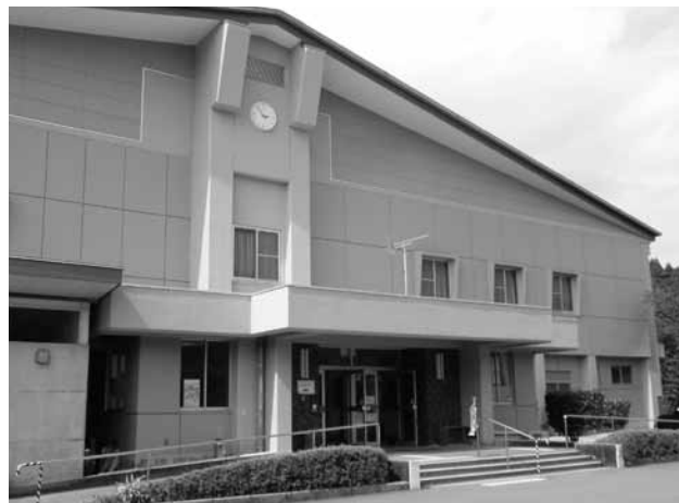
▲天ヶ城公園体育館
