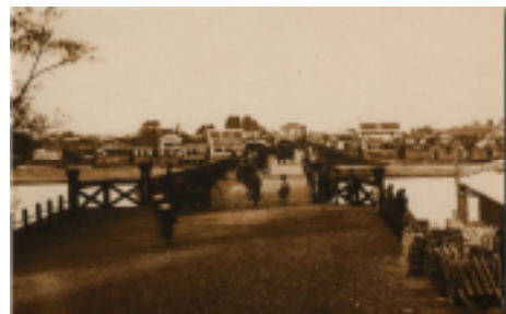
2代目橋橋（明治21年架橋）
