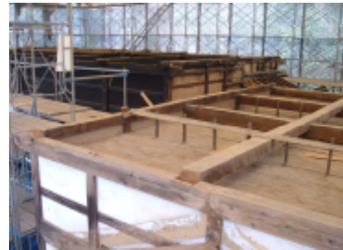
解体工事で現われた小屋裏 ▶
