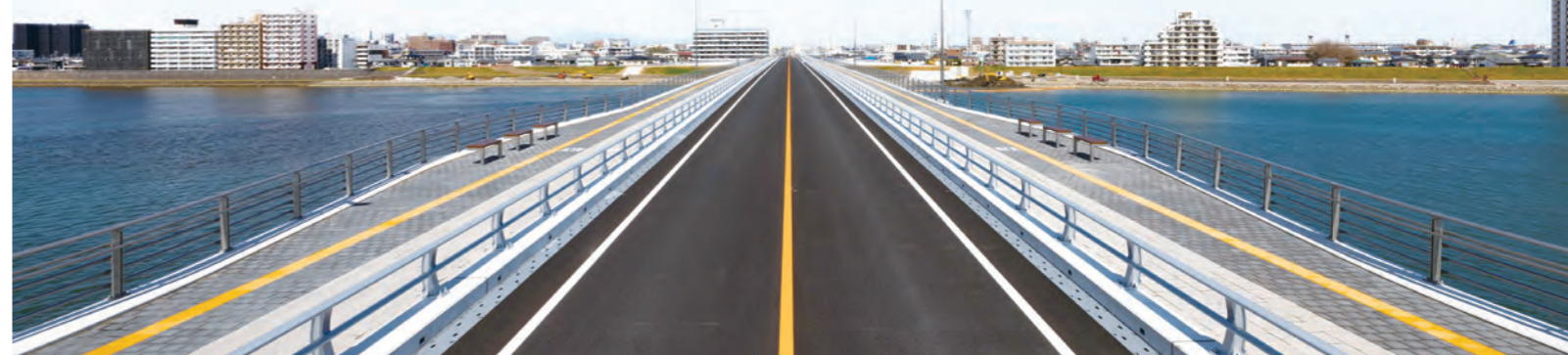
新橋の構造概要 橋種：コンクリート橋 橋長：506m(事業施工延長1.048m) 幅員：16~19m(片側1車線、車道4.5m×2、歩道3.5m×2) 橋台：逆T式橋台 橋脚：壁式橋脚 活荷重：B活荷重
