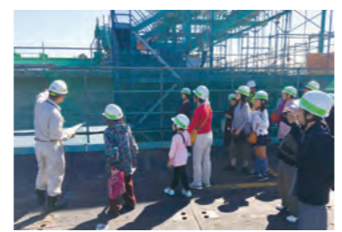
工事現場を地域住民が見学し、理解を深めて協働。
