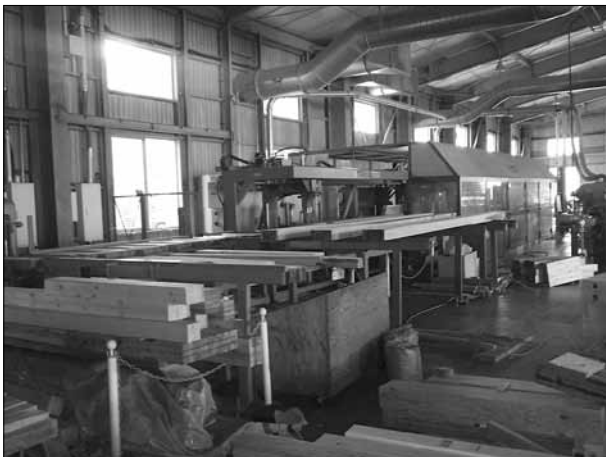
導入された木材加工施設①
