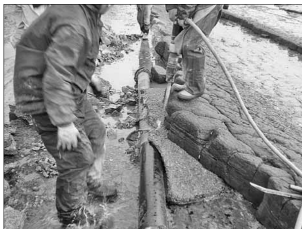
波状岩に放置されていた工作物の撤去工事
