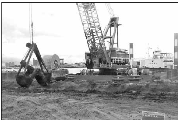
浚渫土砂の揚土
