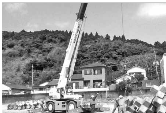
クレーンによる運搬
