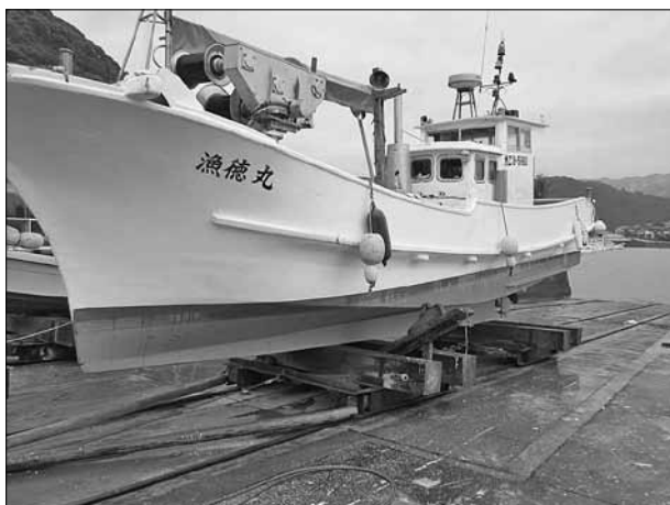
改修した上架施設*
