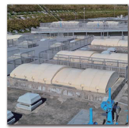
覆蓋により安全性を確保
