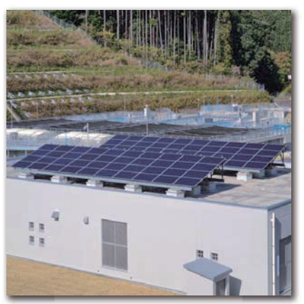
太陽光発電設備
