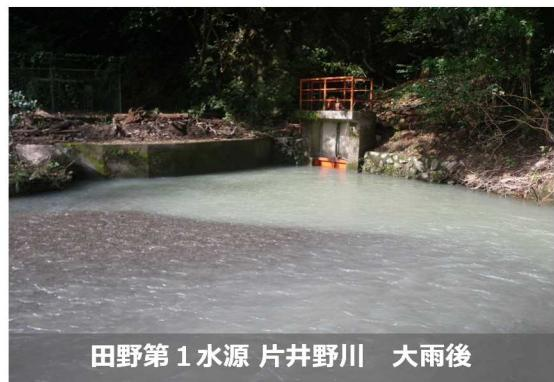
また、田野第1浄水場が大雨時に浄水能力を超える濁りが発生し取水できなくなるため、新たな水源（木場段水源）として片井野川の支流である表流水を追加したところです。
