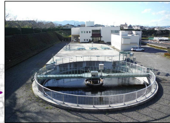
A-3-6 木花処理場水処理施設増設
