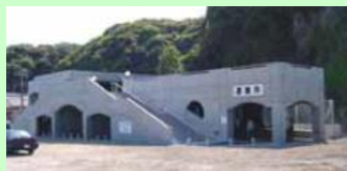
◆津波避難施設
