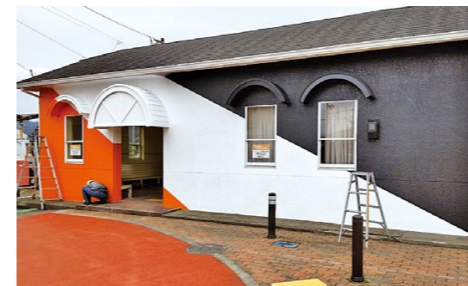
完成間近の駅舎
