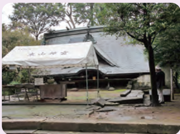
震災で倒壊した木山神宮（益城町）
