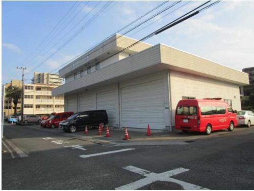
車庫が少なく、緊急車両を屋外に駐車している
