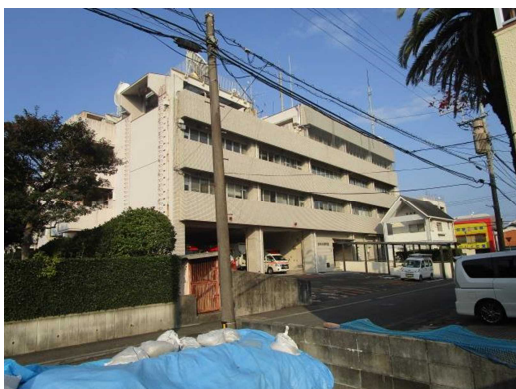
敷地が狭く、訓練施設を整備する場所がない
