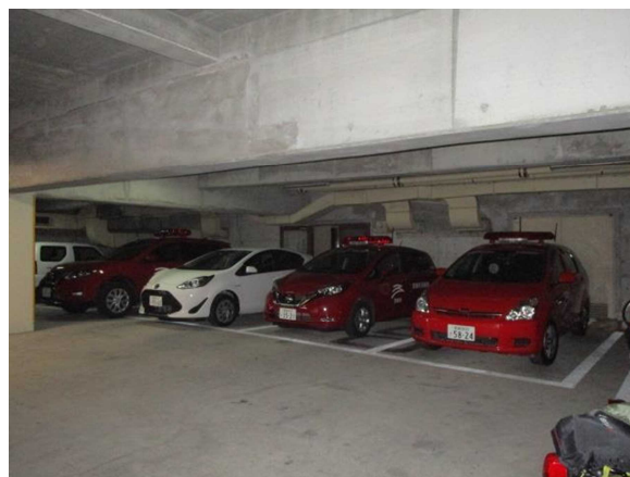
地下駐車場は天井が低く、狭い
