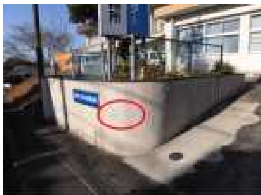
柱の爆裂・ひび割れ
