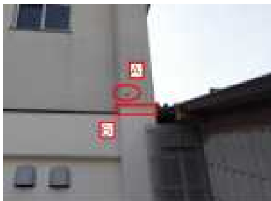
柱の爆裂・ひび割れ
