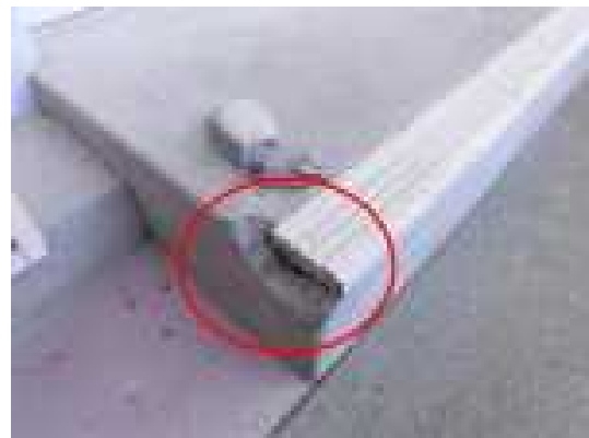
踏み段のモルタル欠損及びノンスリップ タイルの浮き
