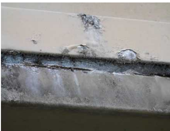
シーリング材の状況
