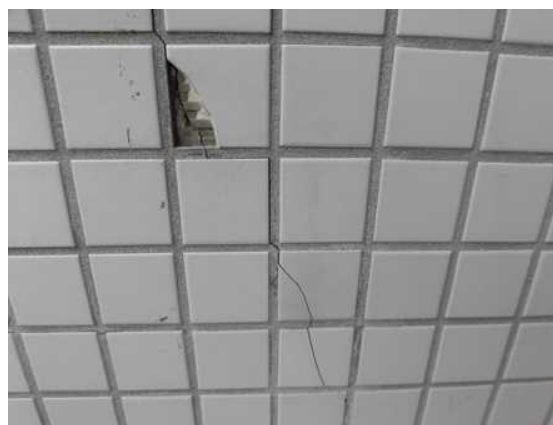
外壁タイルの状況
