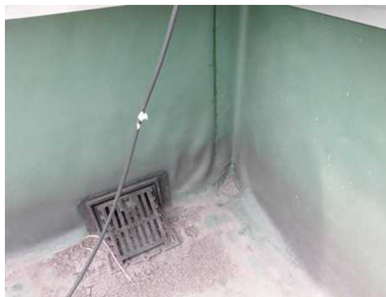
屋上防水シートの状況
