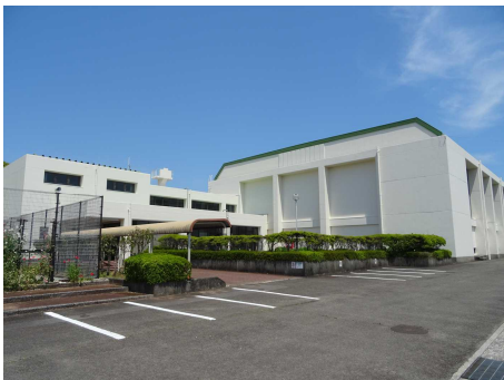
14：加納スポーツセンター
