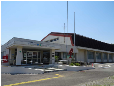
10：B & G海洋センター体育館
