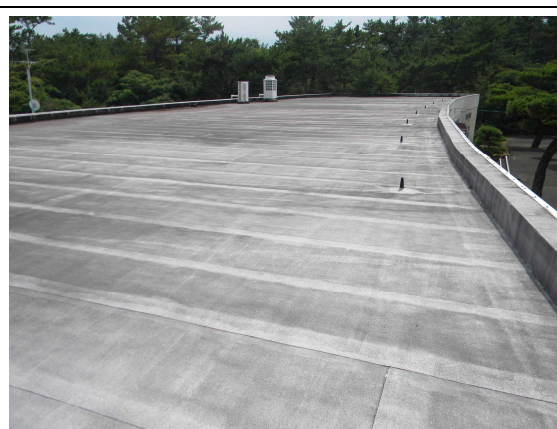
情報プラザ（屋上の状況）
