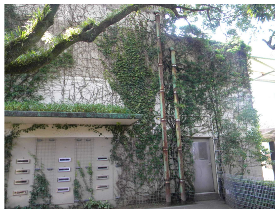
ゾウ舎（外壁の状況）
