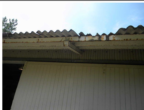
堆肥舎（屋根の状況）
