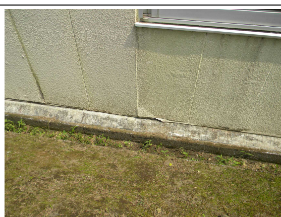
情報プラザ（外壁の状況）
