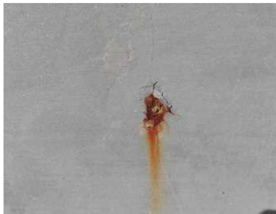
屋上の壁の状況
