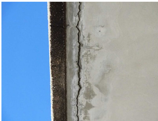
屋上の梁下端の状況
