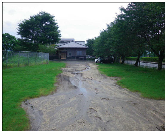
建物敷地全景（東側）
