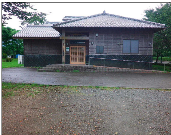
建物全景（東側）
