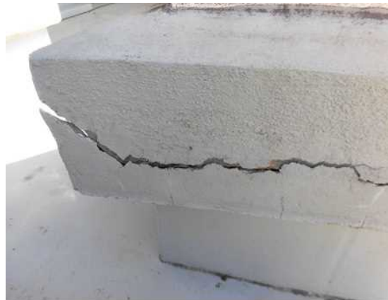
パラペットの状況
