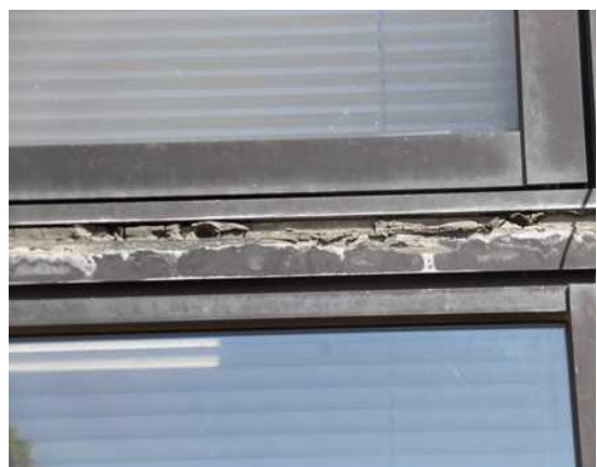
シーリング材の状況
